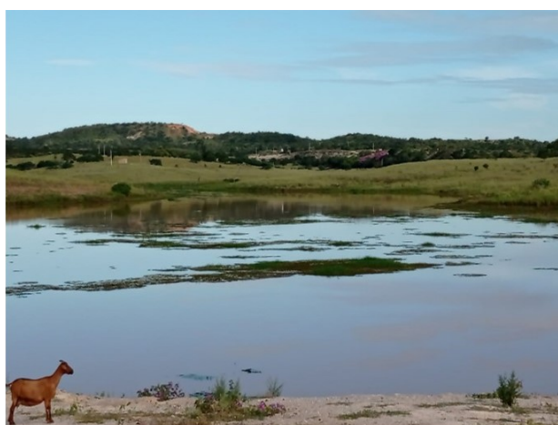
Figura 5: Degradação do Açude Tiririca em Jaicós – PI
