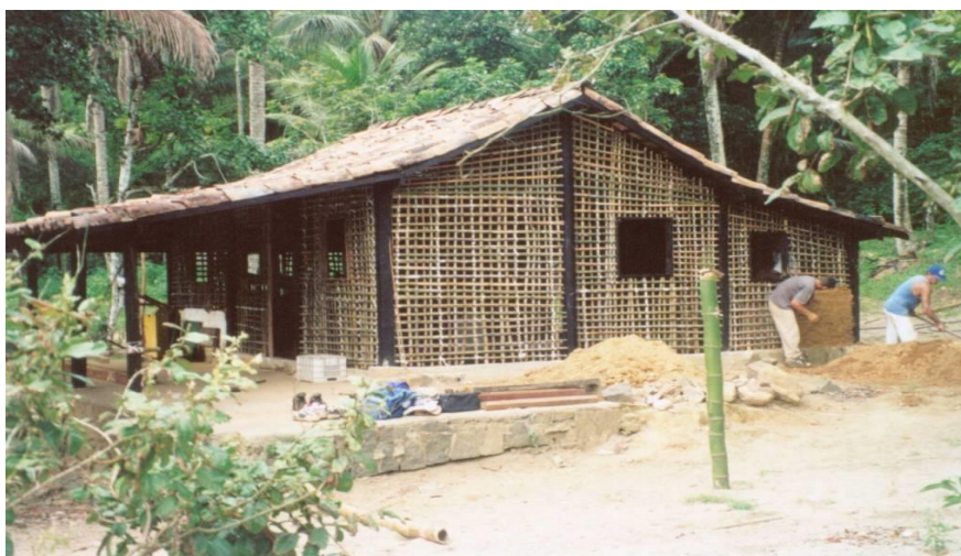
Figura 1. Construção de uma Casa de Taipa sendo construída (detalhes da ossatura feita de bambu)
